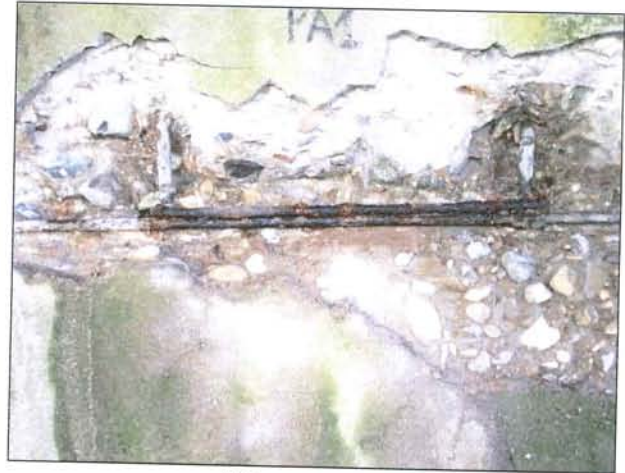
Rilievo armatura
