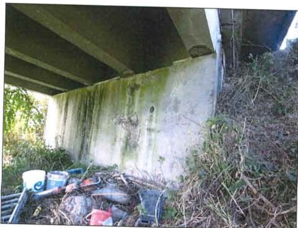
Veduta della spalla in sx idraulica
