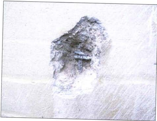
Rilievo armatura
