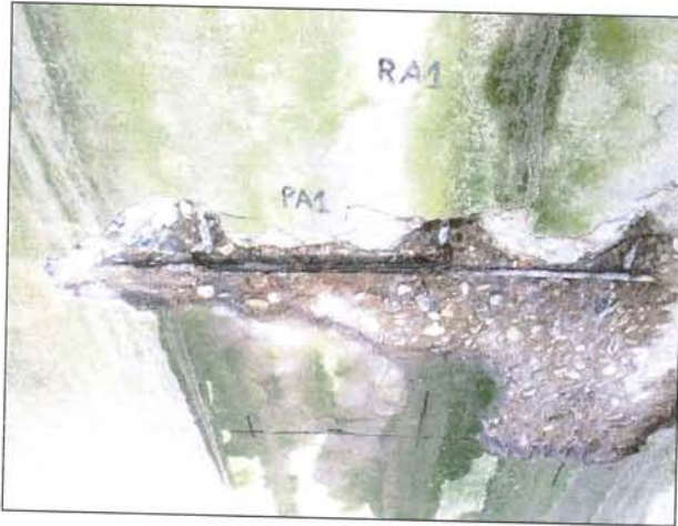
Rilievo armatura
