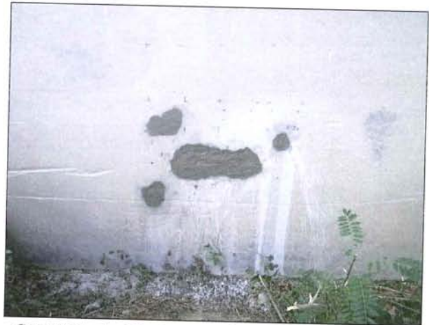
Copriferro ripristinato con malta cementizia tixotropica
