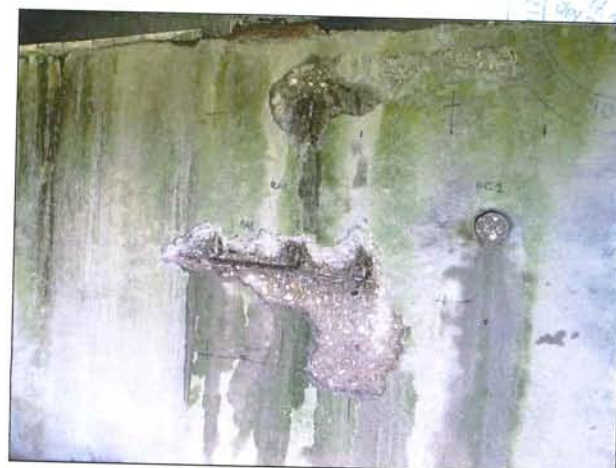
Rilievo armatura
