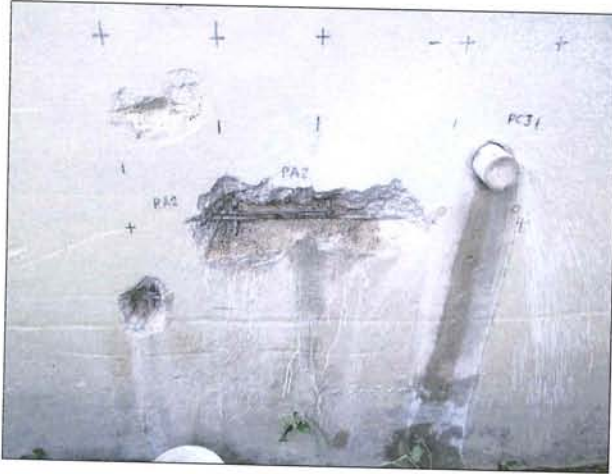
Rilievo armatura
