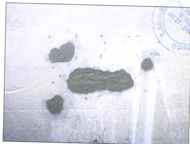
Copriferro ripristinato con malta cementizia tixotropica
