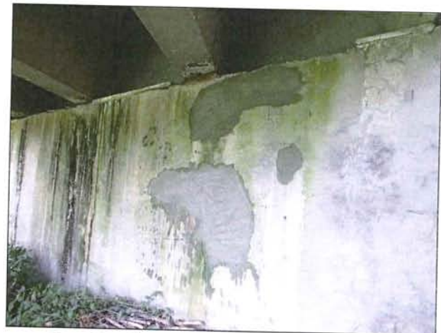
Foro riempito con malta cementizia tixotropica
