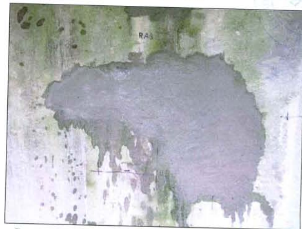
Copriferro ripristinato con malta cementizia tixotropica
