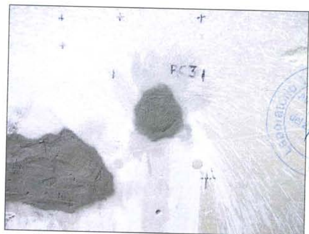
Foro riempito con malta cementizia tixotropica
