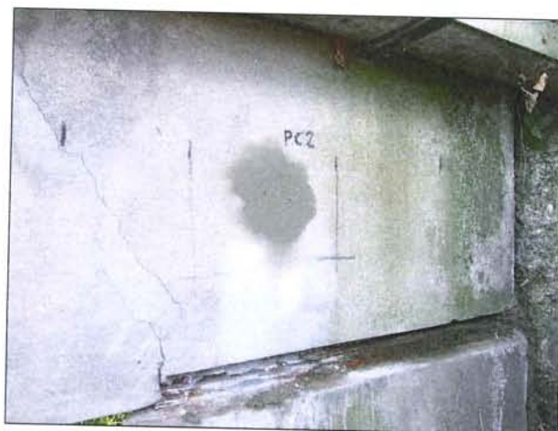
Foro riempito con malta cementizia tixotropica
