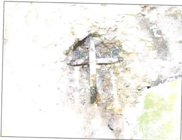
Rilievo armatura
