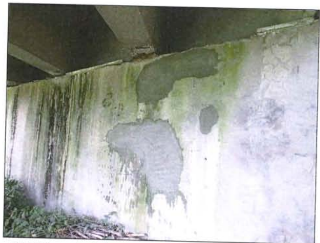
Copriferro ripristinato con malta cementizia tixotropica
