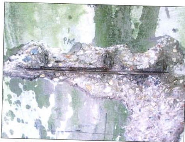
Ripristino mediante saldatura di una nuova barra
